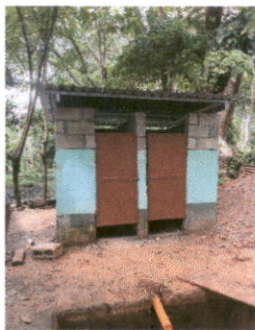
Foto 5: Estructura de techo en baños
