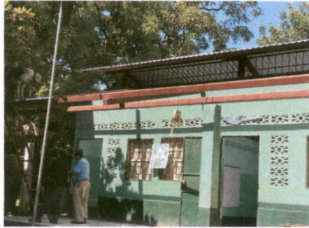
Foto 1: Cubierta de lámina
