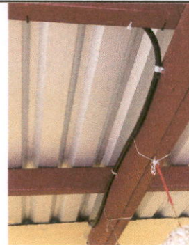
Foto 4: Reparación de sistema eléctrico
