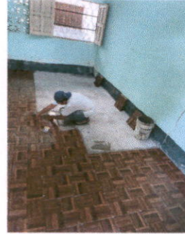
Foto 2: Reparación de piso cerámico
