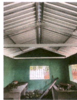
Foto 6: Cubierta de lámina en cocina
