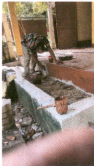
Foto 3: Reparación de losa de patio
